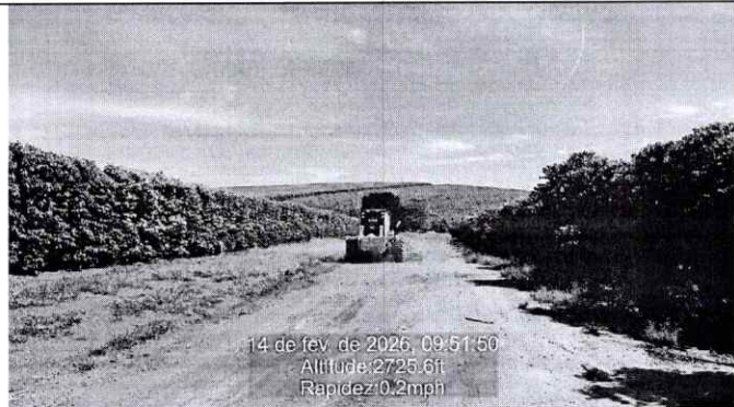
LOCAL OBRA: ESTRADAS DO BAIRRO MUQUIRANA
