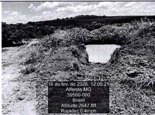
LOCAL OBRA: ESTRADAS DO BAIRRO MUQUIRANA
