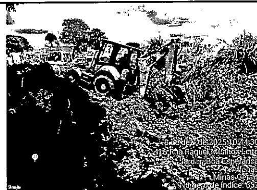
LOCAL OBRA: ANGOLINHA LIMPEZA DE BOLSÕES
