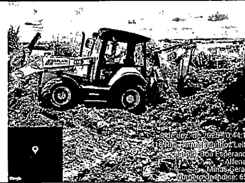
LOCAL OBRA: ANGOLINHA LIMPEZA DE BOLSÕES
