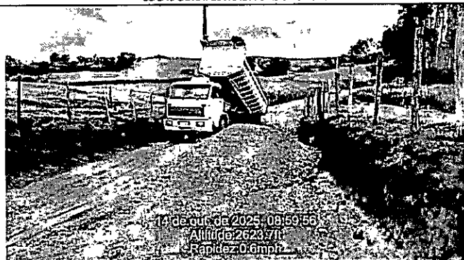
LOCAL OBRA: ESTRADA DAS BRUACAS
