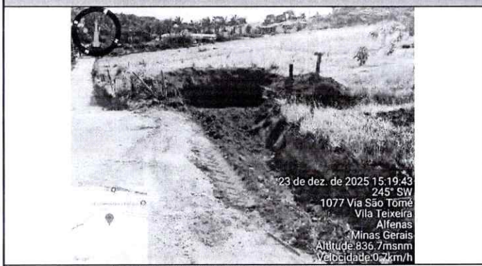
LOCAL DA OBRA: BAIRRO SANTO ME ESTRADAS DE ACESSO (ALFENAS-MG)
