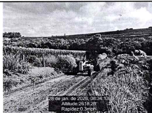
LOCAL OBRA: ESTRADAS DO BAIRRO MUQUIRANA
