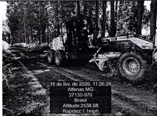
LOCAL OBRA: ESTRADAS DO BAIRRO MUQUIRANA
