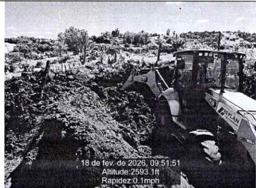
LOCAL OBRA: ESTRADAS DO BAIRRO MUQUIRANA
