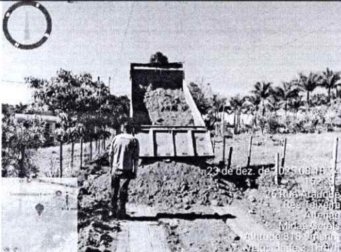
LOCAL DA OBRA: BAIRRO SANTO ME ESTRADAS DE ACESSO (ALFENAS-MG)
