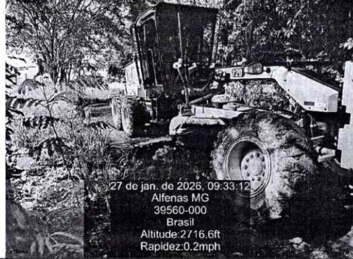
LOCAL OBRA: ESTRADAS DO BAIRRO MUQUIRANA
