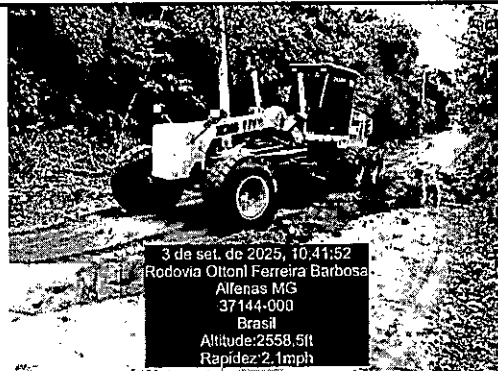
03/09/2025 - LOCAL: ROD. OTTONI FERREIRA BARBOSA - ALFENAS A FAMA - Regularização de Base
