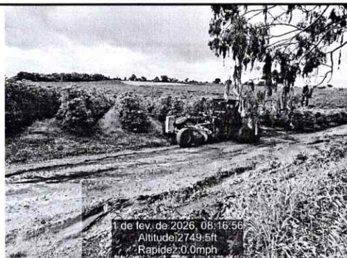
LOCAL OBRA: ESTRADAS DO BAIRRO MUQUIRANA
