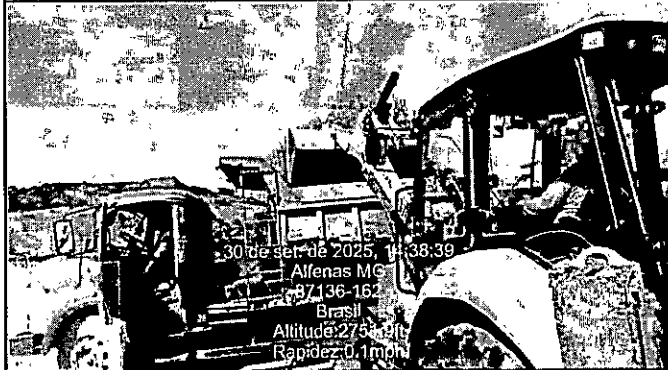
LOCAL OBRA: ESTRADA DAS BRUACAS
