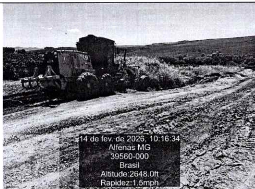
LOCAL OBRA: ESTRADAS DO BAIRRO MUQUIRANA
