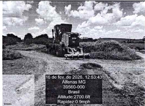
LOCAL OBRA: ESTRADAS DO BAIRRO MUQUIRANA
