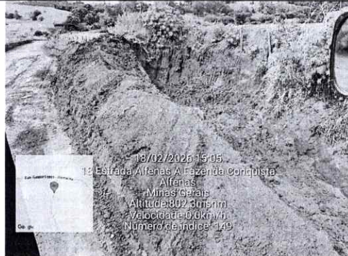
LOCAL OBRA: ESTRADAS DO BAIRRO MUQUIRANA
