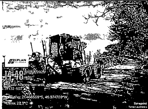
LOCAL DA OBRA: ESTRADA VIA DE SÃO THOME - REGULARIZAÇÃO DE BASE
