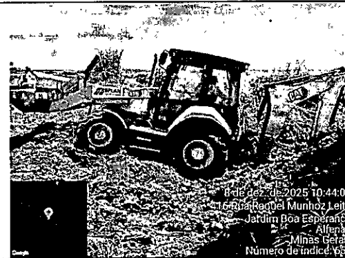
LOCAL OBRA: ANGOLINHA LIMPEZA DE BOLSÕES
