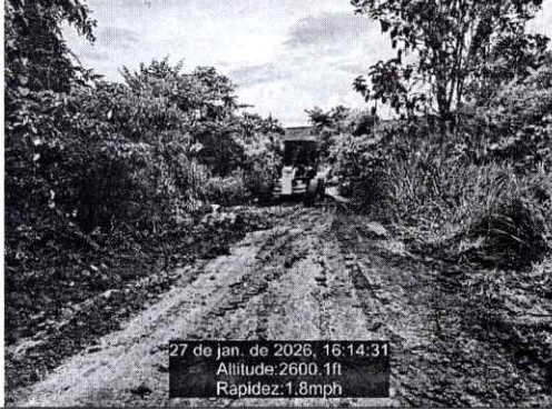
LOCAL OBRA: ESTRADAS DO BAIRRO MUQUIRANA
