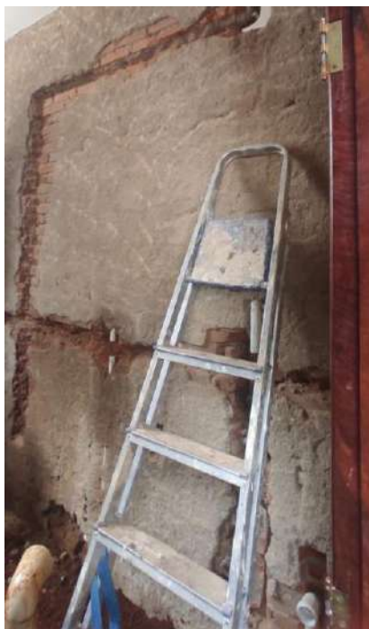
Remoção de revestimento cerâmico
