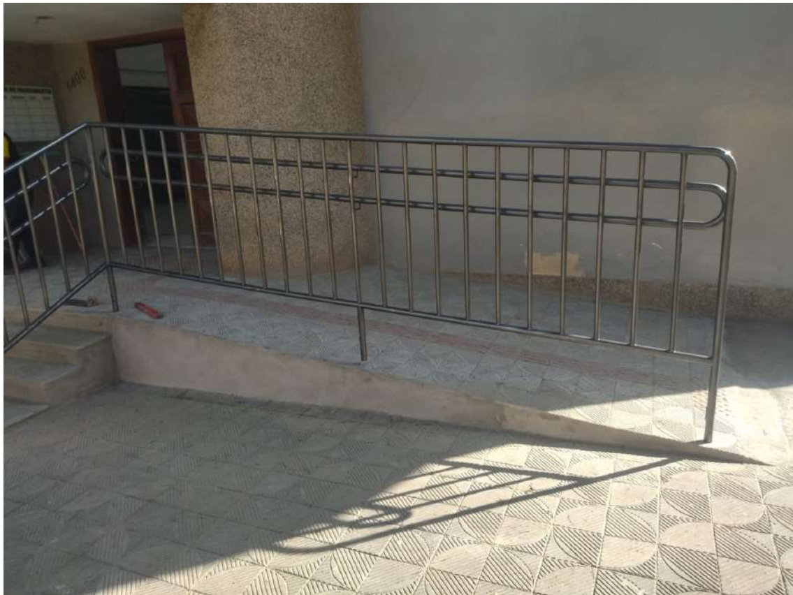
Guarda corpo de aço galvanizado
