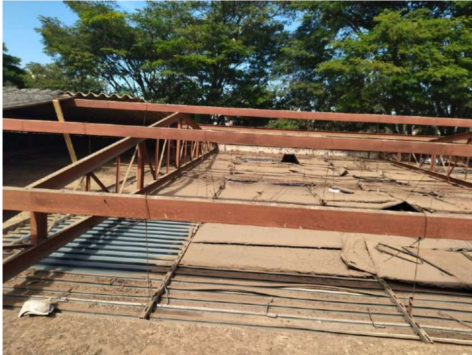
Remoção do telhado
