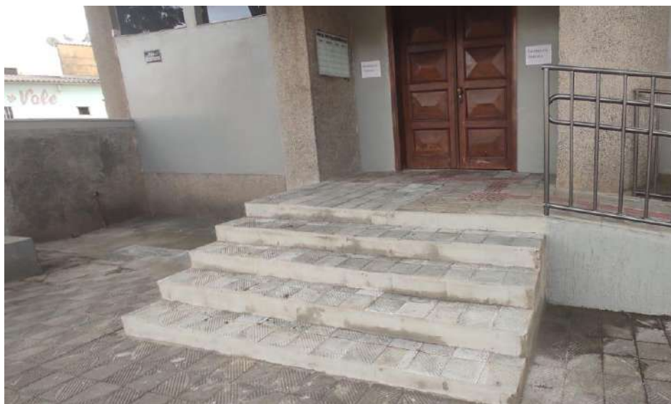
Piso em ladrilho hidráulico aplicado em ambientes externos
