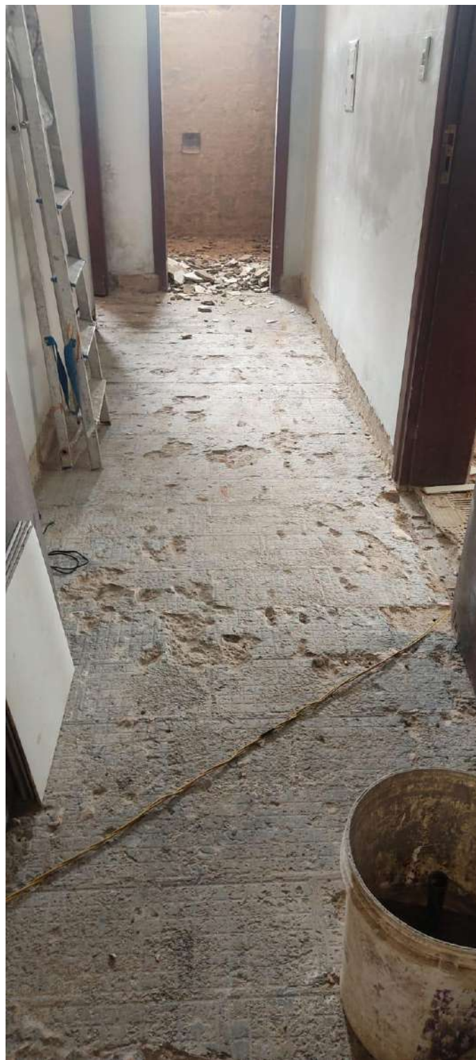
Demolição do revestimento cerâmico do piso do corredor
