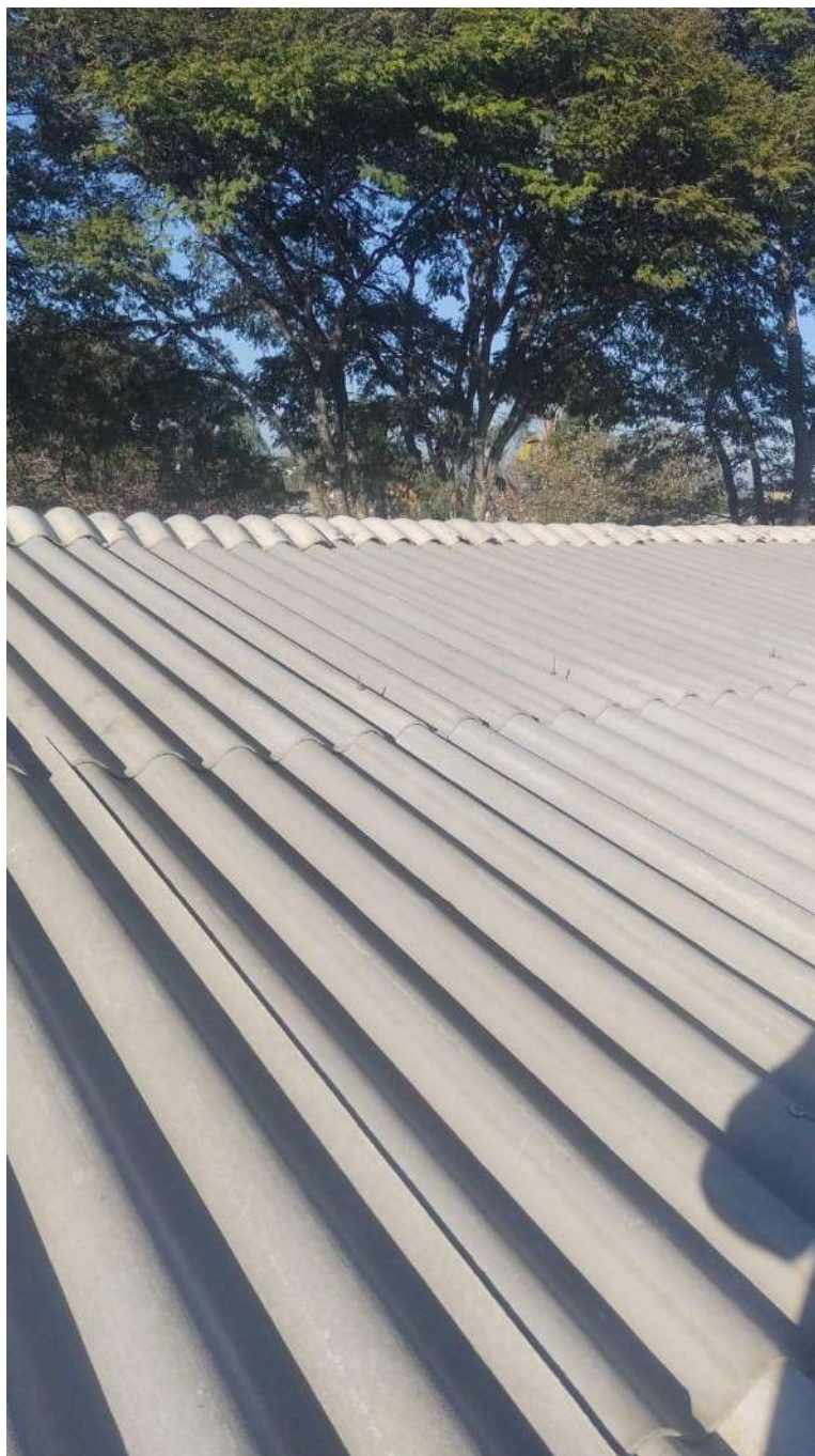
Telhamento com telha ondulada de fibrocimento
