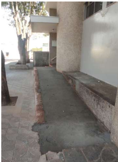
Execução da rampa de acesso ao Velório
