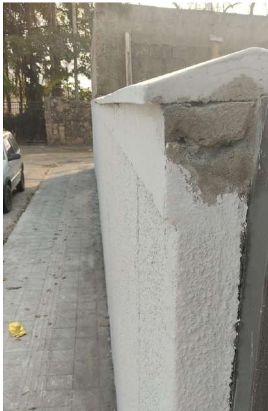
Colocação do chapéu de muro
