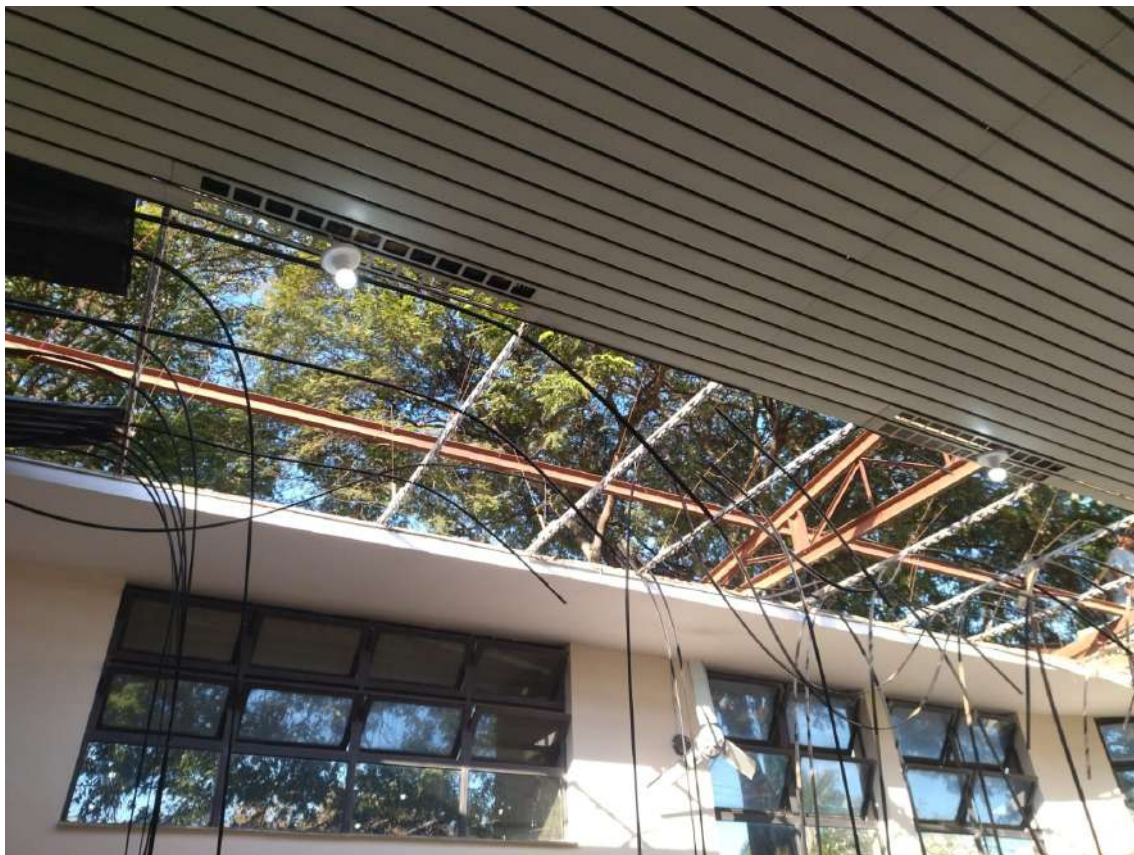
Remoção do telhado
