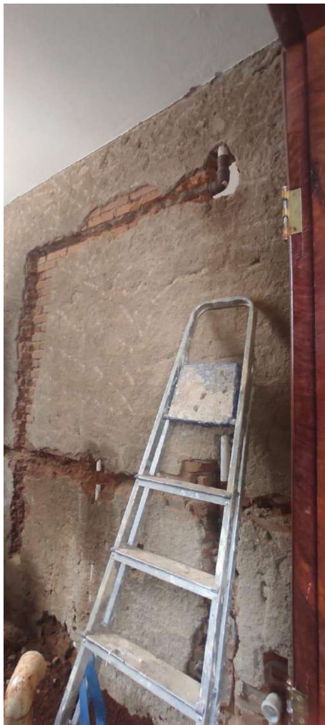
Demolição do revestimento cerâmico da parede do banheiro
