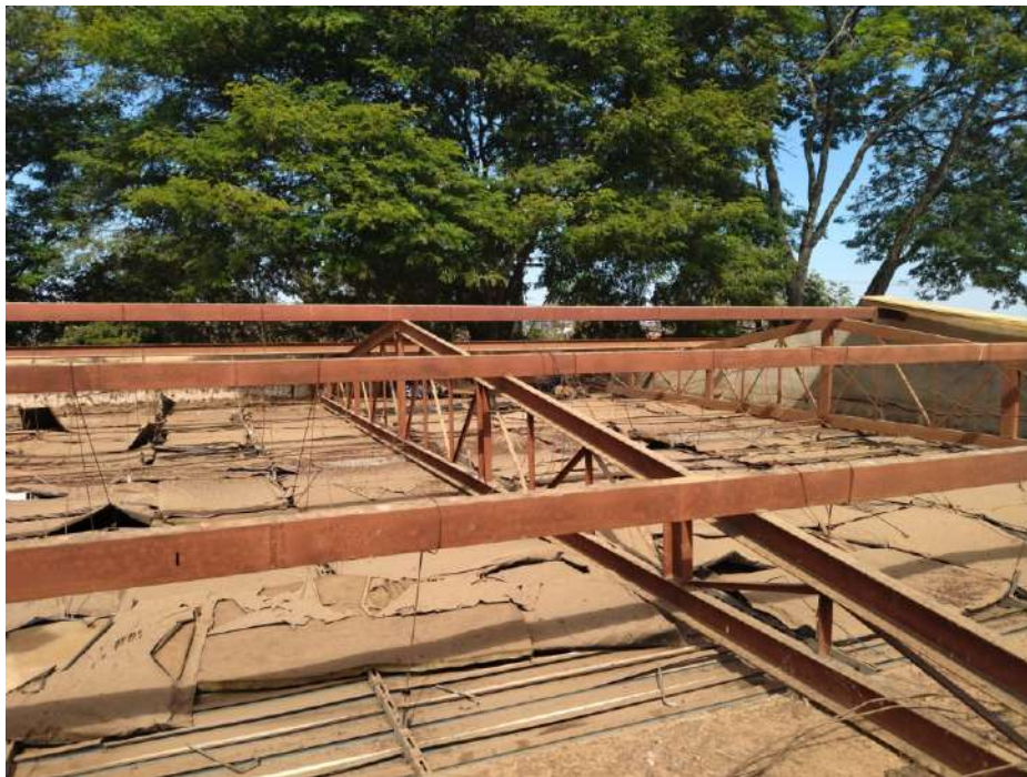
Remoção do telhado
