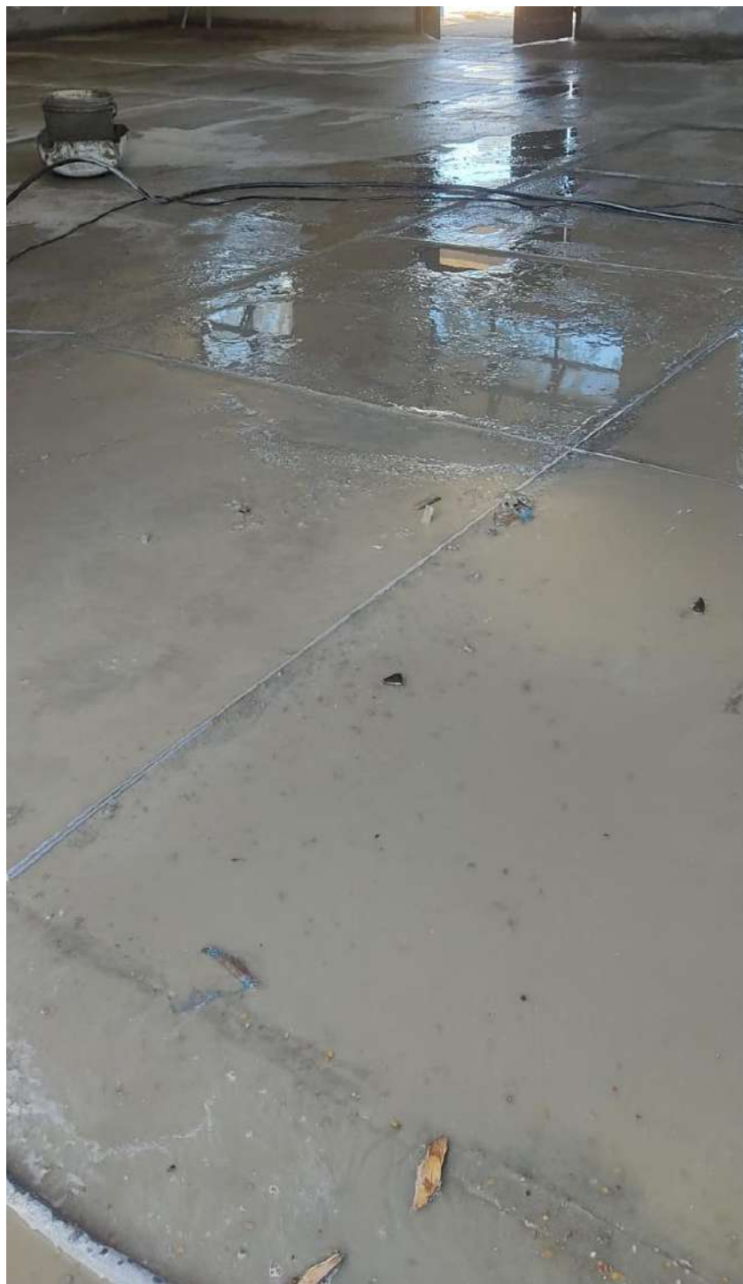
Execução do piso granilite
