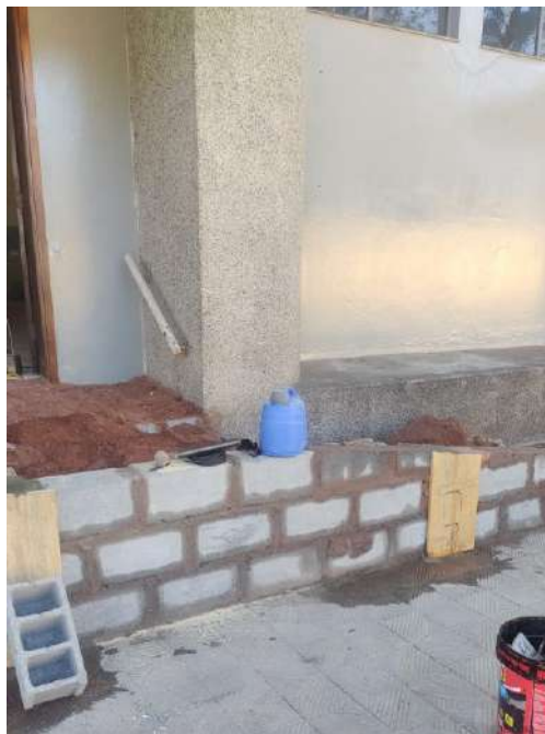
Execução da rampa de acesso ao Velório
