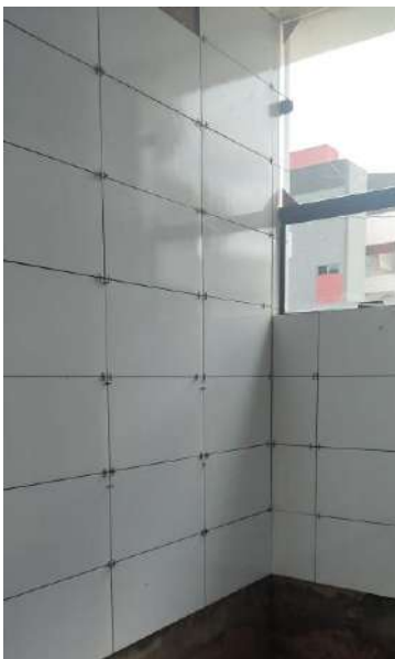
Revestimento cerâmico da parede do banheiro
