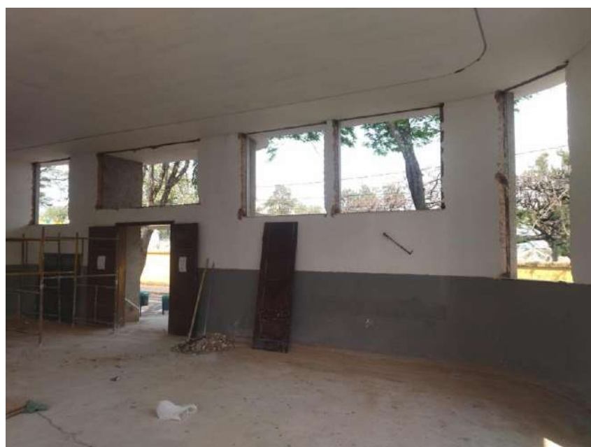
Remoção das janelas
