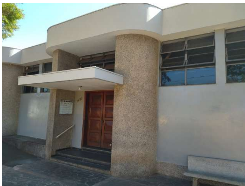
Pintura externa executada
