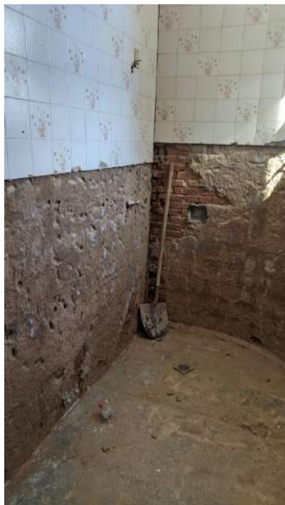
Remoção de revestimento cerâmico
