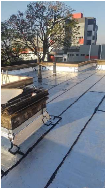
Impermeabilização de superfície com manta asfáltica
