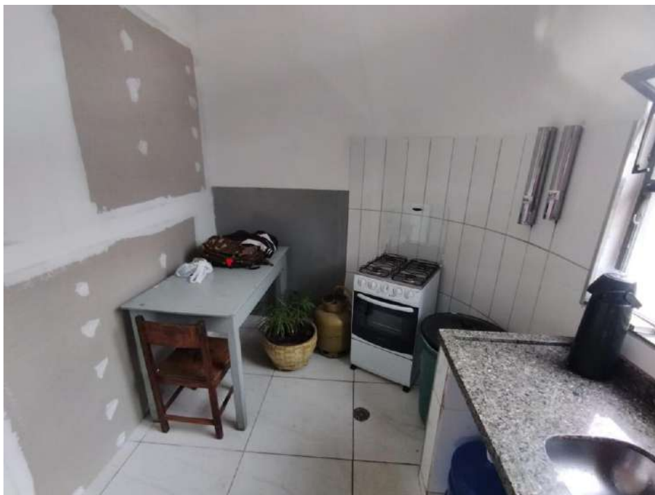
Parede com sistema em chapas de gesso
