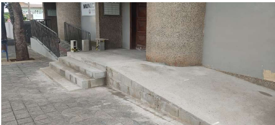
Execução da escada e rampa do segundo saguão
