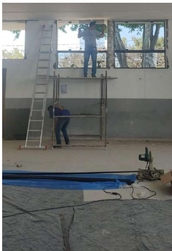
Troca das janelas
