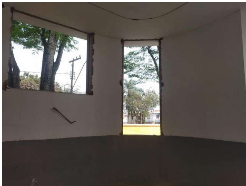
Remoção das janelas
