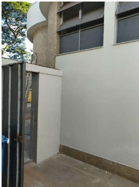
Pintura externa executada
