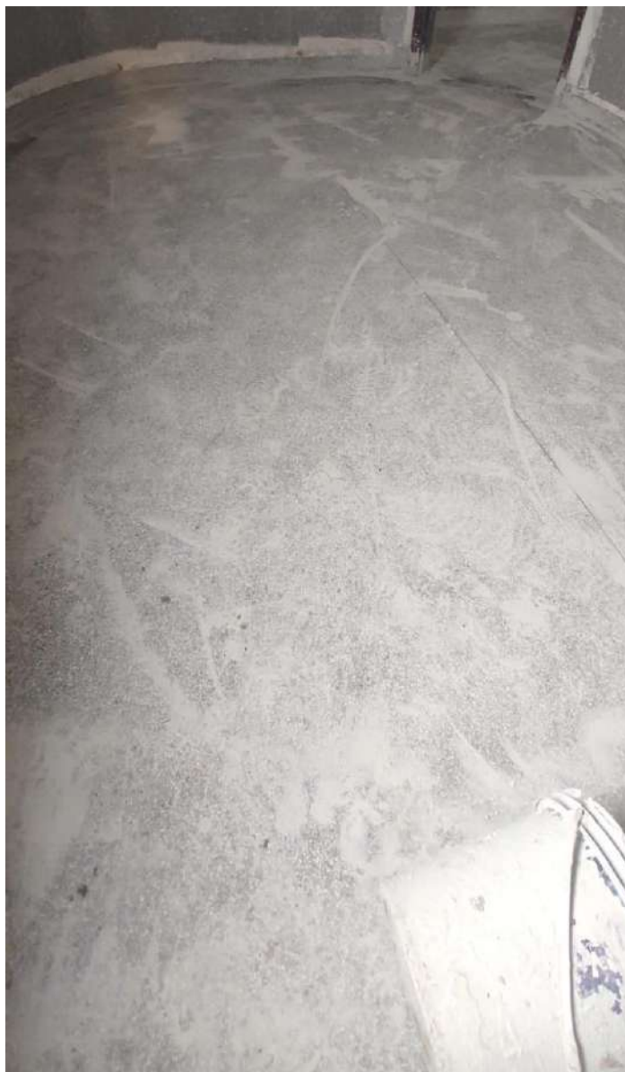
Execução do piso granilite
