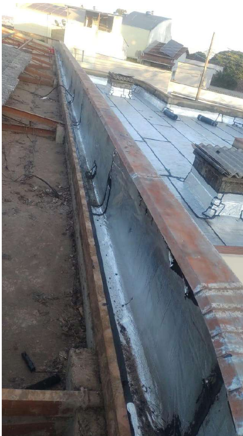
Impermeabilização de superfície com manta asfáltica
