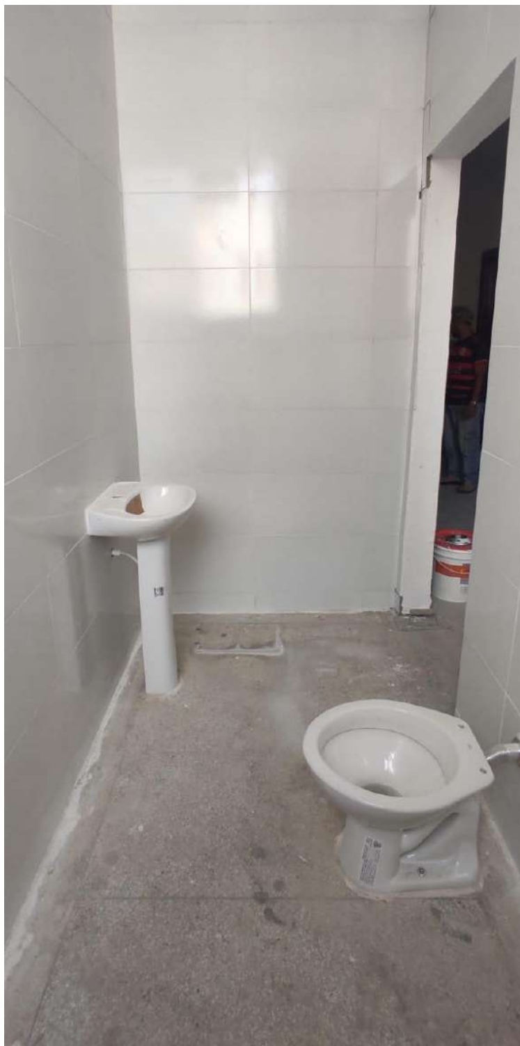
Lavatório e vaso sanitário instalados
