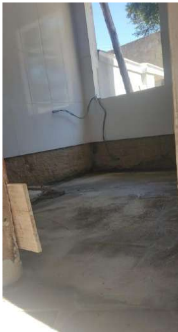
Revestimento cerâmico da parede e contrapiso
