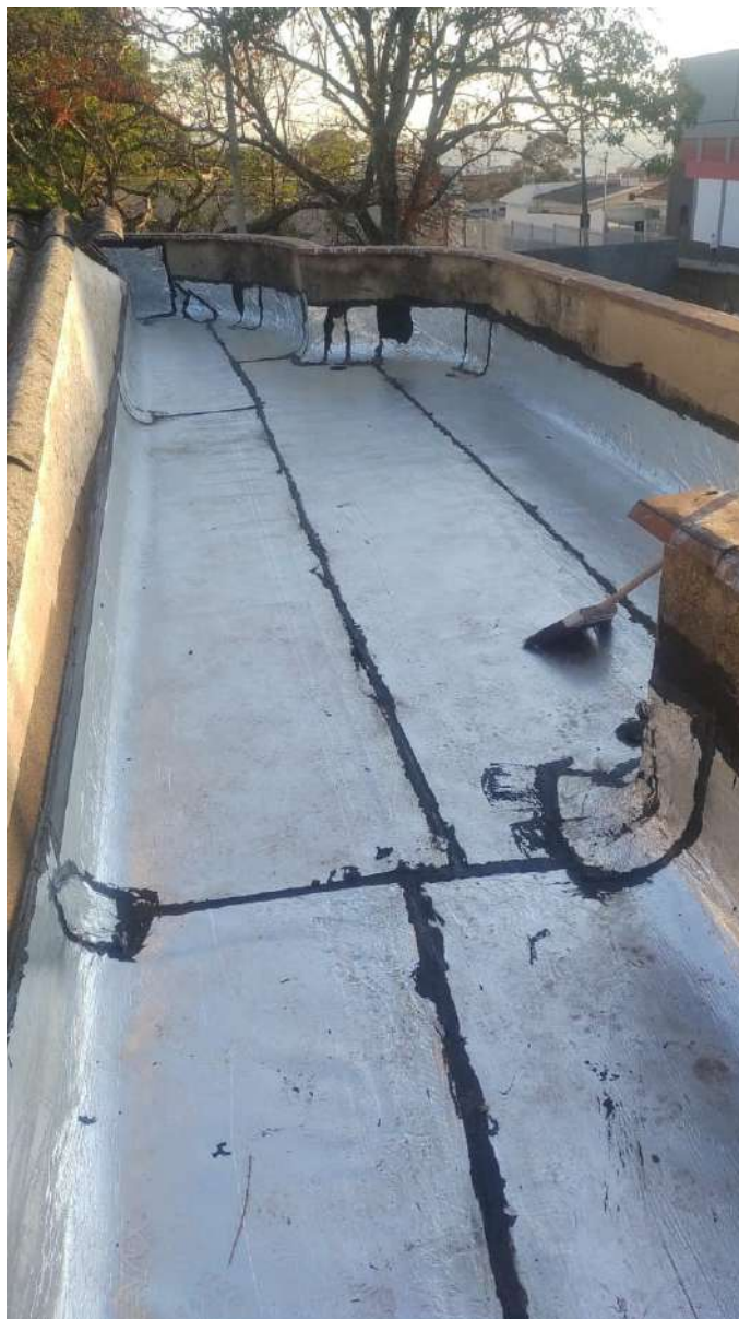
Impermeabilização de superfície com manta asfáltica
