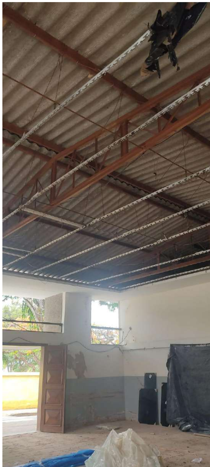
Remoção do forro de madeira
