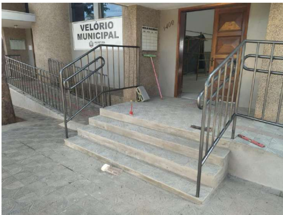
Guarda-corpo de aço galvanizado
