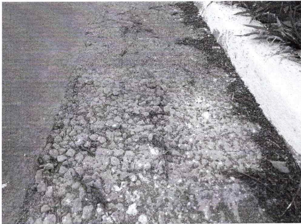
Figura 08 – Material granular aparente
