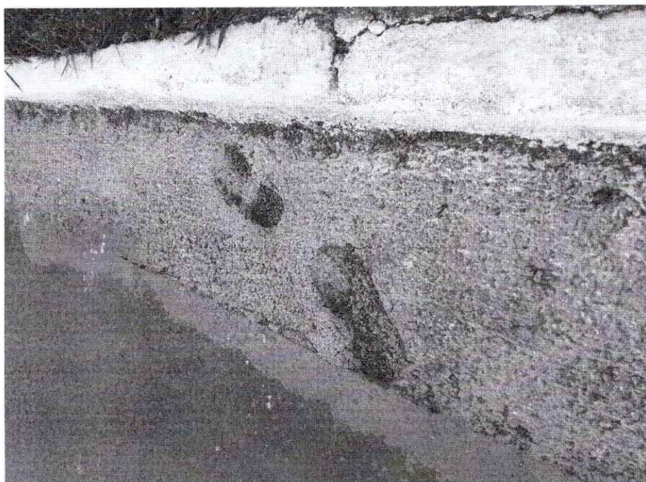
Figura 05 – Pegadas em sarjeta
