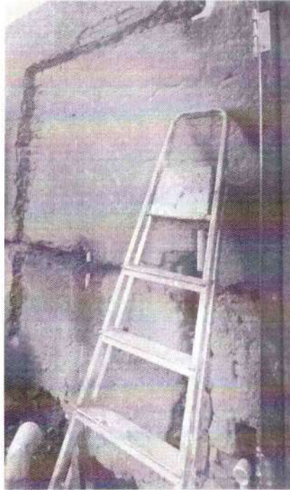
Remoção de revestimento cerâmico
