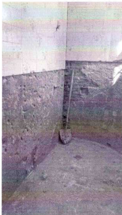
Remoção de revestimento cerâmico
