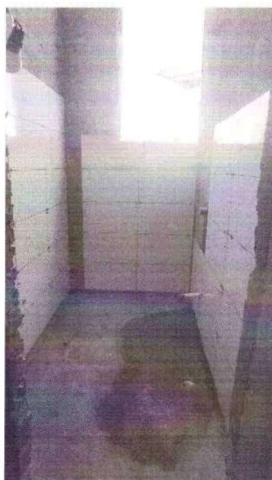
Revestimento cerâmico para paredes internas
