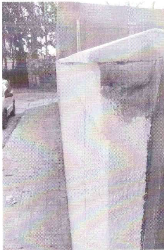
Colocação do chapéu de muro
