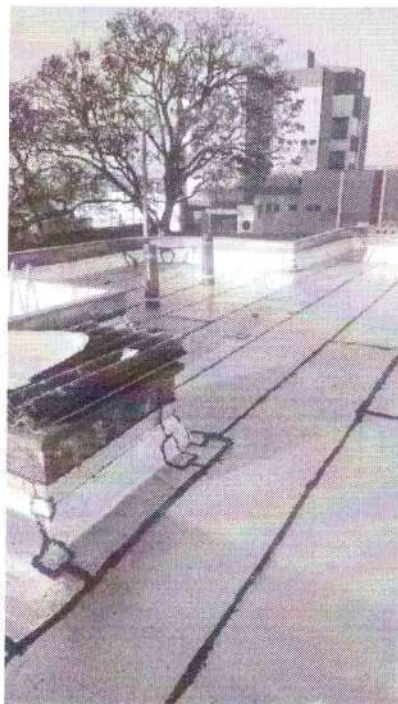
Impermeabilização de superfície com manta asfáltica
