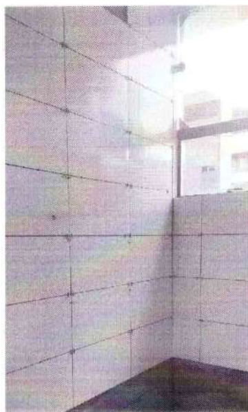
Revestimento cerâmico da parede do banheiro
