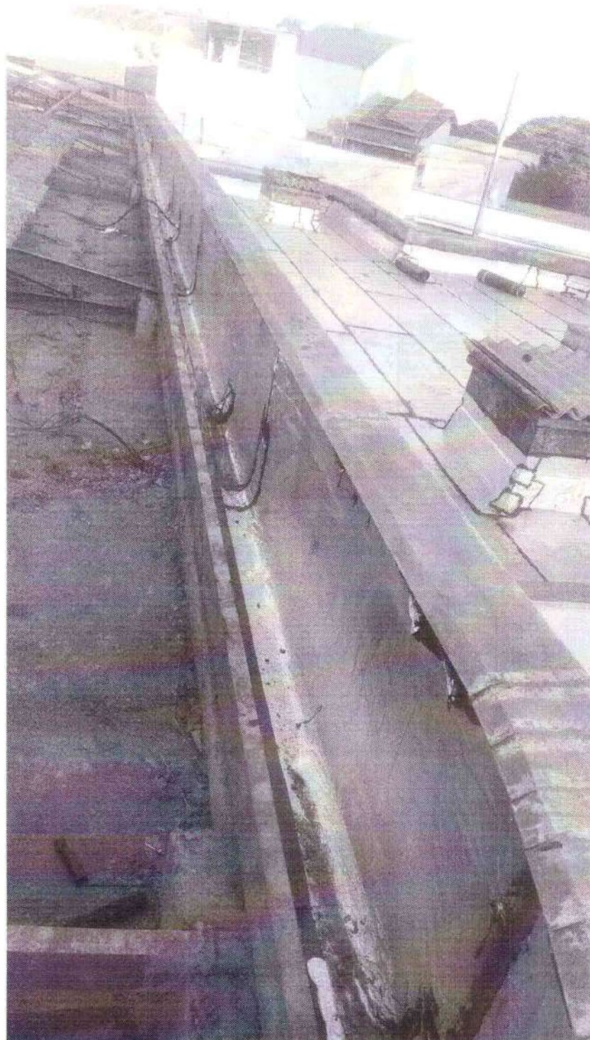
Impermeabilização de superfície com manta asfáltica
