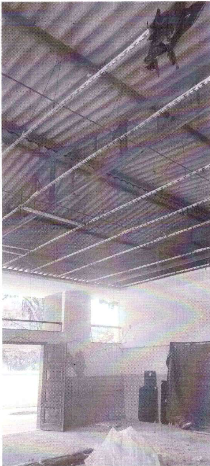
Remoção do forro de madeira
